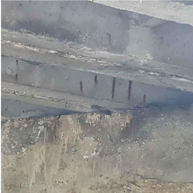
OBNAŽENÁ BV NA VNÚTORNEJ STRANE NOSNÍKOV
