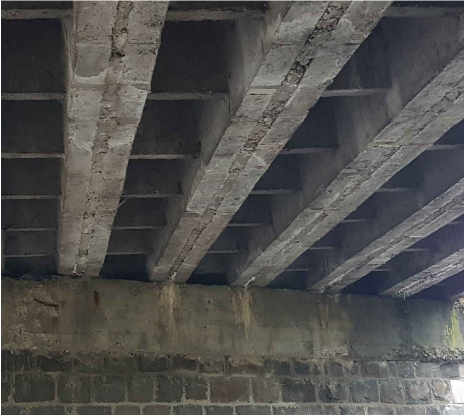
DEGRADOVANÝ BETÓN V SPOJI NOSNÍKOV
