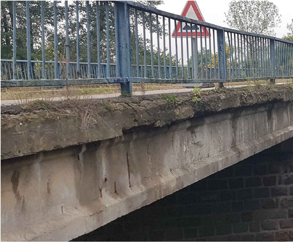
OBNAŽENÁ BV NA VNÚTORNEJ STRANE NOSNÍKOV
